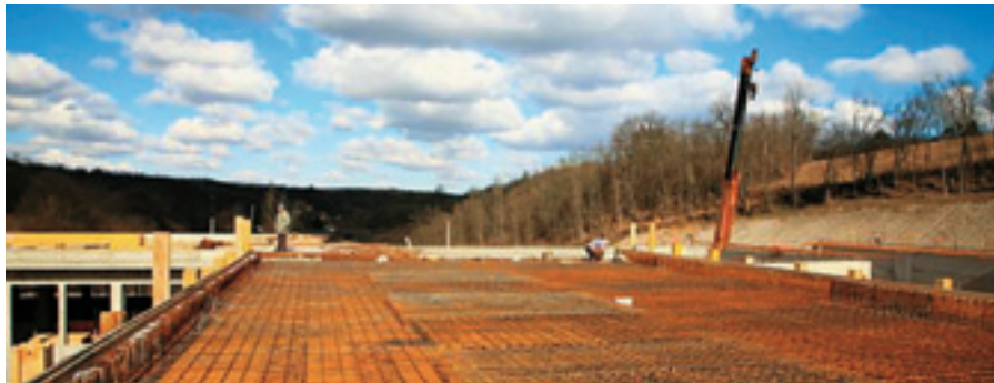
Costruzioni degli edifici in superficie sul terreno del deposito finale di Bataapati (Ungheria).
