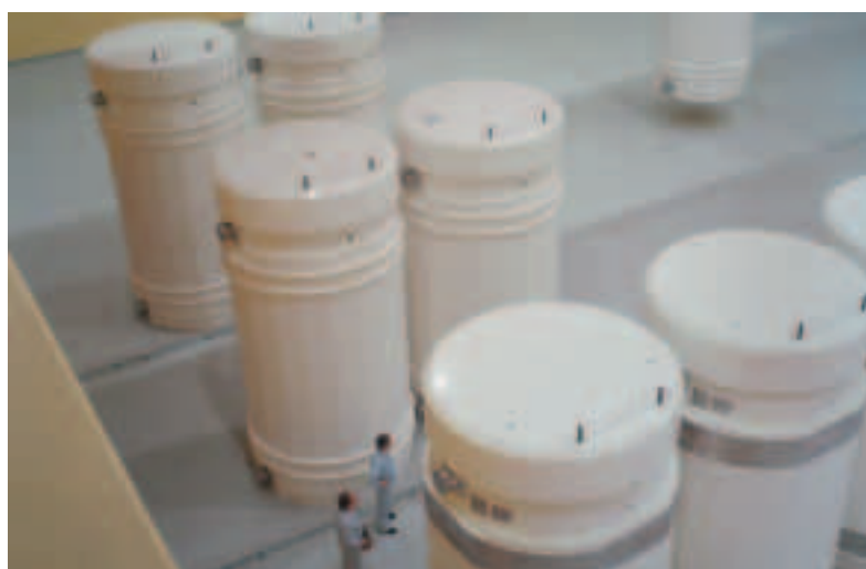
Nel deposito centrale intermedio di Würenlingen (ZWILAG) si trovano attualmente 22 contenitori da deposito con elementi esausti di combustibile e 8 contenitori contenenti scorie vetrificate altamente attive. (Foto ZWILAG)
