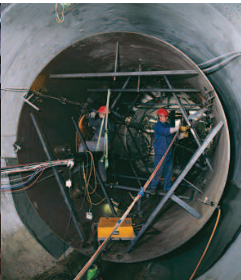
Lavori di installazione del nuovo sistema di packer per gallerie per l'esperimento sui colloidi. (Foto Comet)
