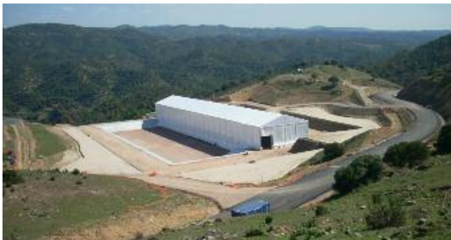
Il terreno del primo dei quattro impianti progettati di El Cabril. (Foto ENRESA)
