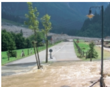
Fotografia KWO del 23.8.05: la strada a Guttannen in direzione sud.
