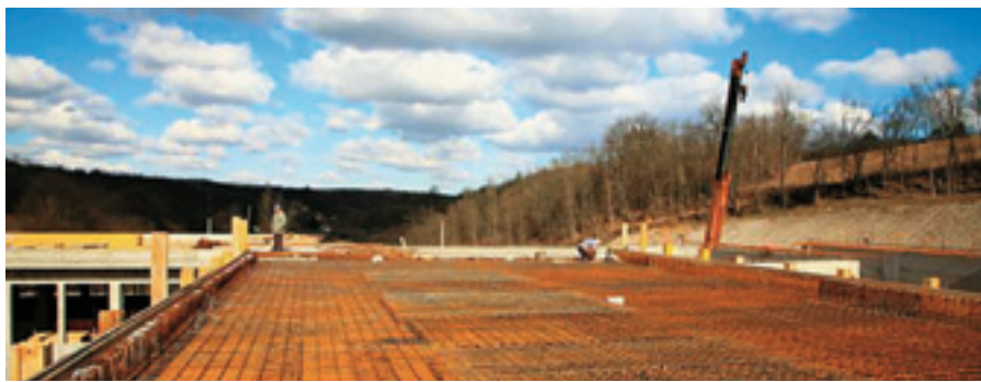
Construction de bâtiments en surface sur le terrain du dépôt final de Bataapáti (Hongrie).
