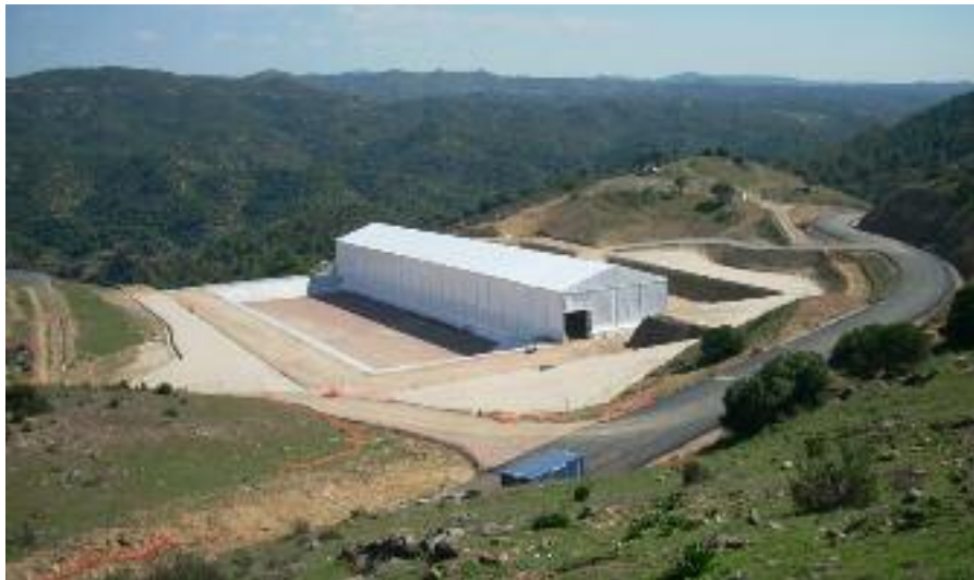
Site de la première des quatre installations prévues à El Cabril. (Photo ENRESA)
