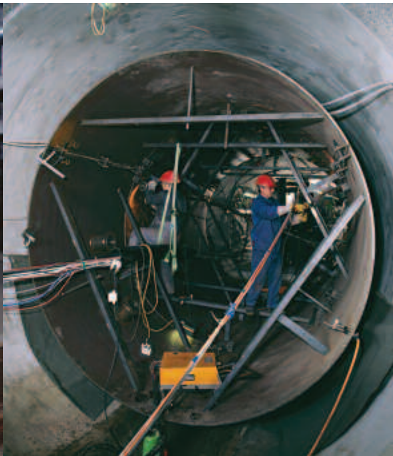
Installation du nouveau système d'obturation de tunnel pour l'essai sur les colloïdes. (Photo Comet)
