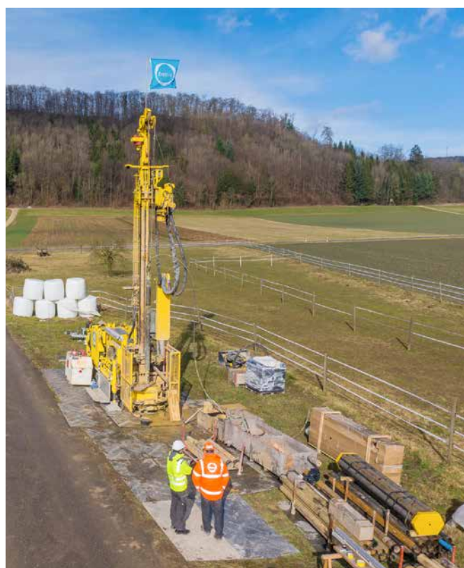
Foreuse et chantier du forage quaternaire à Riniken (AG). Plus d'informations sous www.nagra-blog.ch . Photo: Nagra
