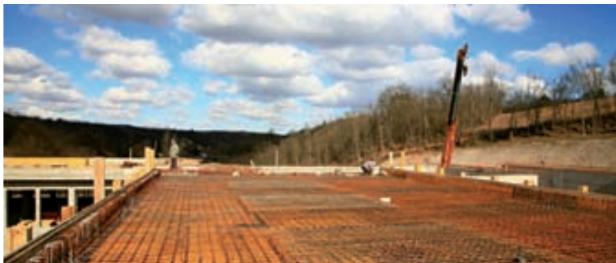
Bau von Oberflächengebäuden auf dem Gelände des Endlagers Bataapáti (Ungarn).
