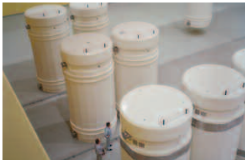
Im Zwischenlager Würenlingen befinden sich zurzeit 22 Lagerbehälter mit ausgedienten Brennelementen und 8 Behälter mit verglasten, hochaktiven Abfällen. (Foto: ZWILAG)
