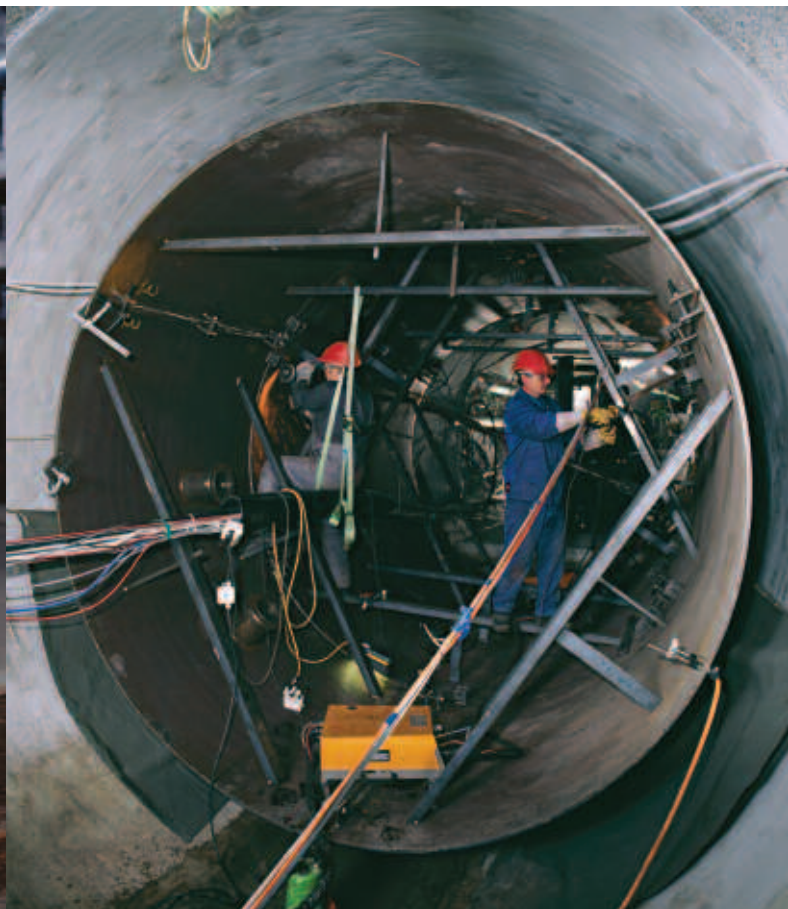
Einbauarbeiten des neuartigen Tunnelpackersystems für den Kolloidversuch. (Foto Comet)
