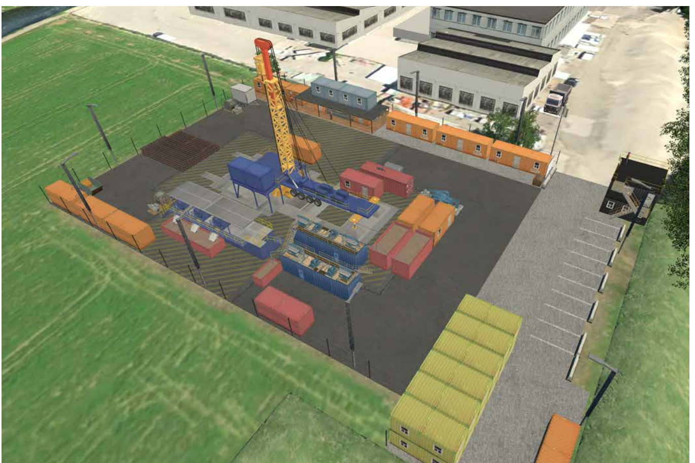
Modellansicht des Bohrplatzes in Bülach, Nördlich Lägern. In der Mitte des rund 0,7 Hektar grossen Platzes steht der Bohrturm. (Foto: Nagra)
