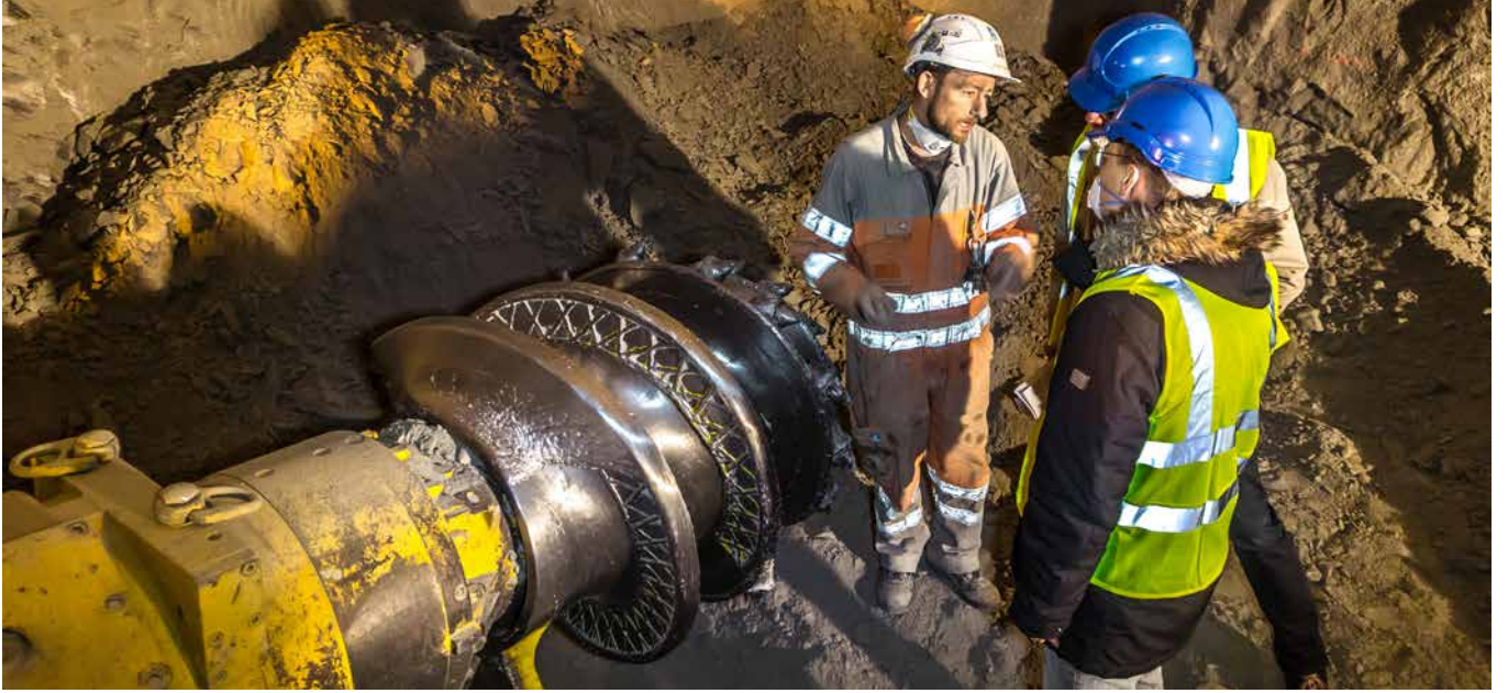
So baut man einen Tunnel im Opalinuston: Der Operateur der Teilschnittmaschine erklärt Besuchenden des Felslabors Mont Terri seine anspruchsvolle Arbeit. Foto: Nagra
