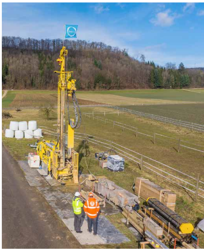
Bohrgerät und Bohrplatz der Quartärbohrung in Riniken (AG). Mehr dazu unter www.nagra-blog.ch . Foto: Nagra
