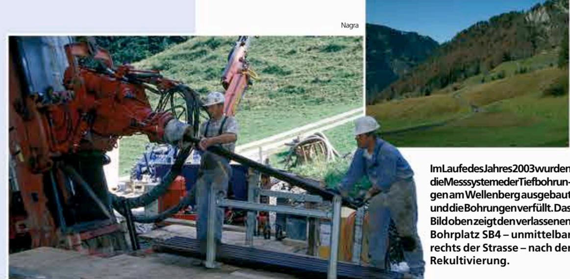
Im Lauf des Jahres 2003 wurden die Messsysteme der Tiefbohrungen am Wellenberg ausgebaut und die Bohrungen verfüllt. Das Bild oben zeigt den verlassenen Bohrplatz SB4 – unmittelbar rechts der Strasse – nach der Rekultivierung.
