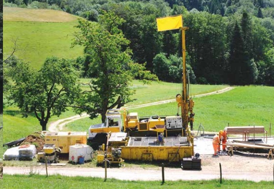
Temporäre Bohrstelleninstallation
