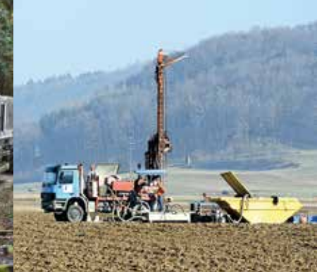
Bohrgerät für eine Aufzeitbohrung
