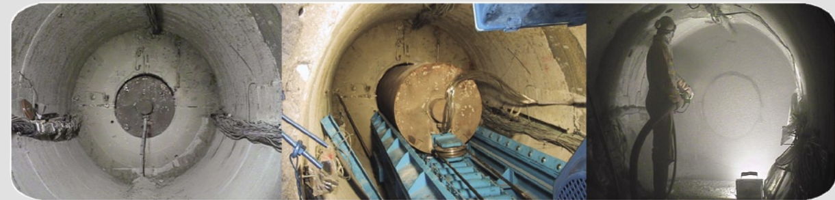
Nach dem Entfernen des Erhitzers wurde eine kleine Behältertrappe (ohne Heizelemente) eingebaut, bevor wieder ein neuer Betonverschluss mit einer neuartigen Spritzbetontechnik eingebracht werden konnte.
