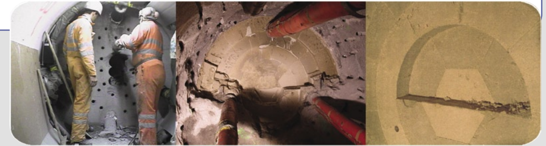
Dabei wurde der Bentonverschluss entfernt und der Bentonit freigelegt. Es zeigte sich, dass sich die ursprünglich zwischen den einzelnen Bentonitblöcken vorhandenen Spalten (vgl. Bild auf der gegenüberliegenden Seite) nach der Aufsättigungsphase durch Quellung des Bentonits geschlossen haben.
