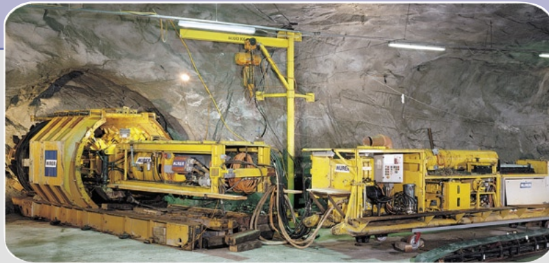
Der FEBEX-Stollen wurde 1996 mit Hilfe einer Vollschnitt-Tunnelbohrmaschine (Stollendurchmesser: 2.3 m) erstellt.
